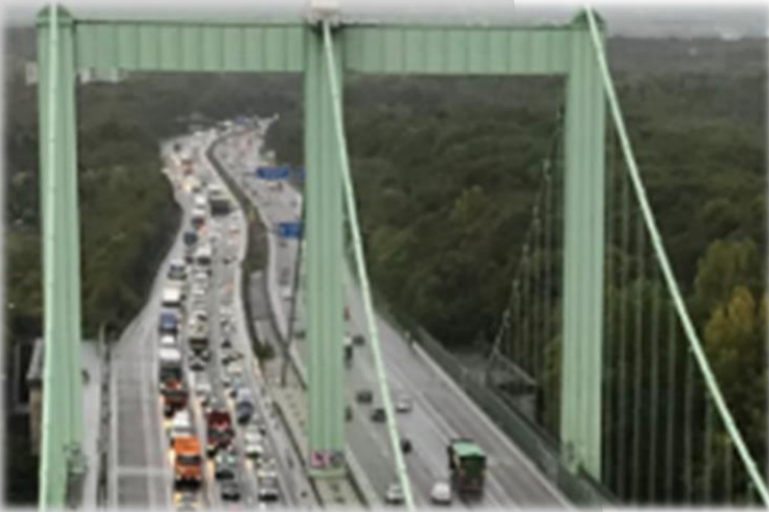
Abbildung: Luftbild der bestehenden Verschwenkung der A4
