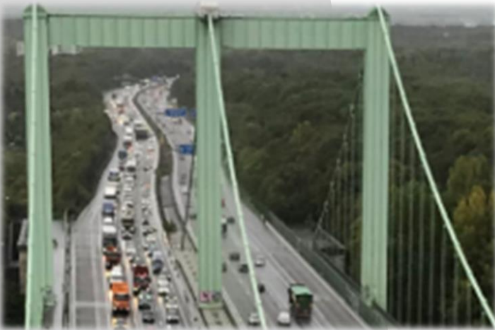
Abbildung: Luftbild der bestehenden Verschwenkung der A4
