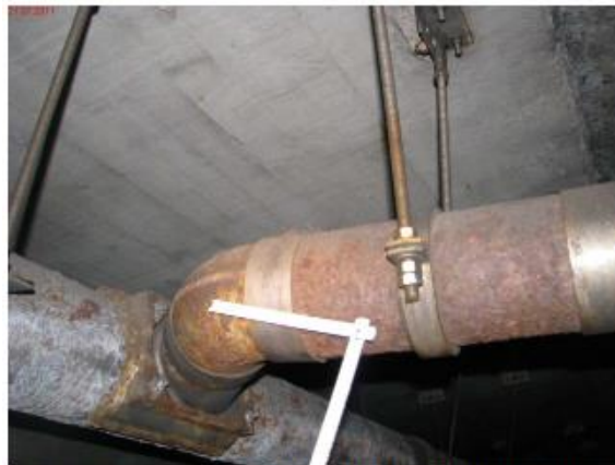
5008583_1_11H_KORRODIERTE ROHRLEITUNGEN
