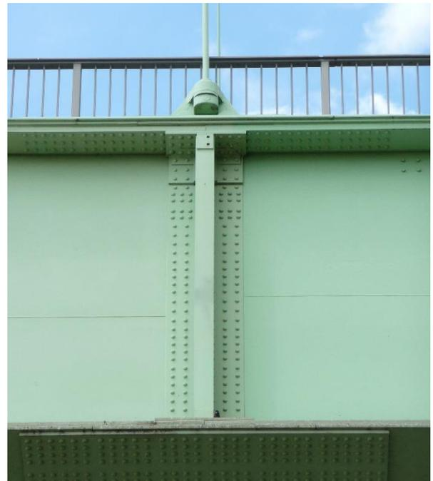
Abbildung 15 Detail Hängeranschluss an VT, aus Plan 5/805-02; Ansicht VT C
