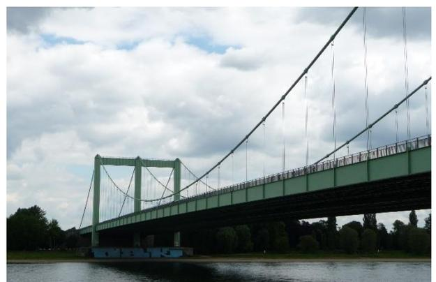
Abbildung 2: Bauwerk 1954 und Bauwerk 1995 mit den drei Kabelebenen
