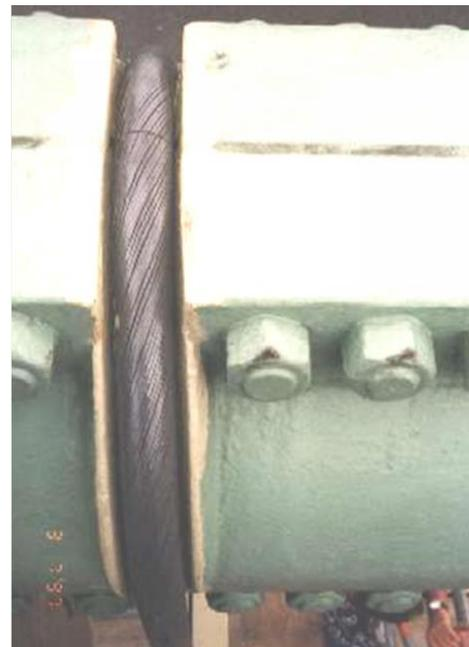
Abbildung 6 Hänger beim Einbau 1996 / Umlenkradius an der Kabelschelle
